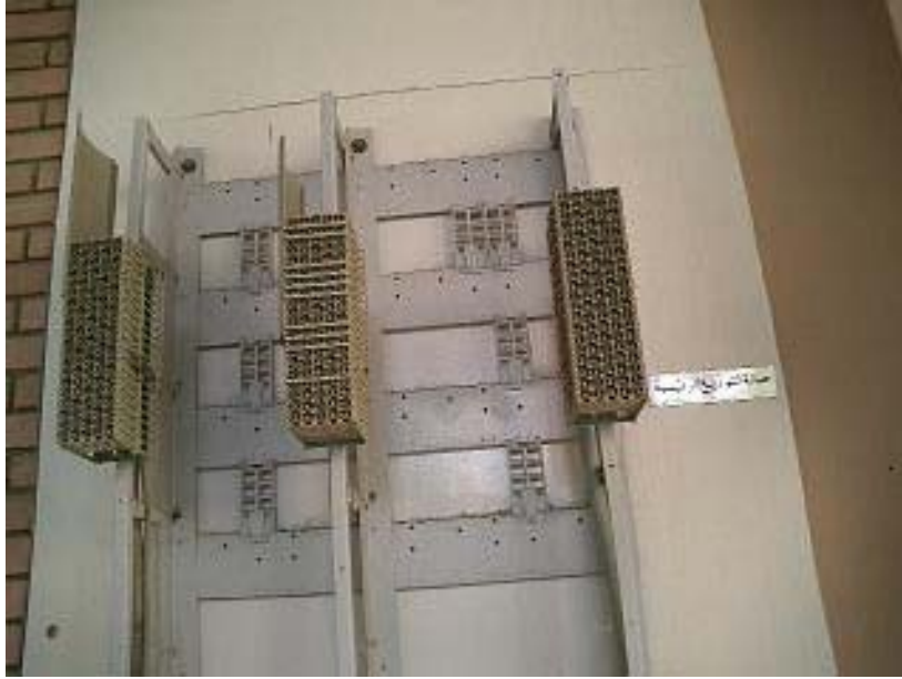
شكل ( ١ ) يوضح نموذج وحدات توصيل هيكل التوزيع الرئيس MDF
